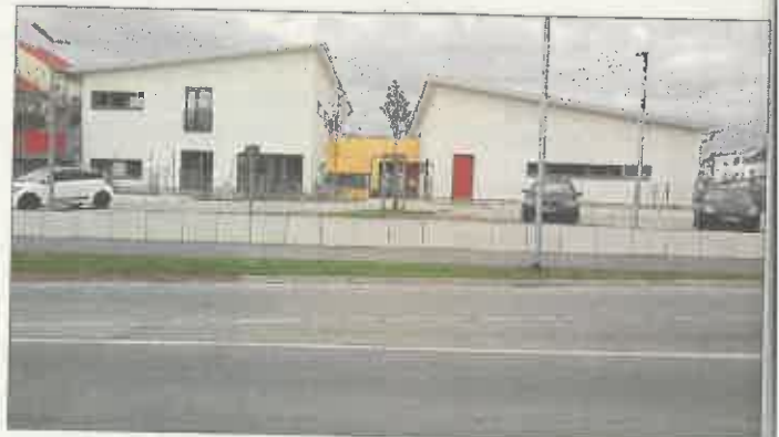
Zwischen der Straße (Philippsanlage) und dem Eingang zur „Kita am Park“ liegen ein Fußweg und ein Grünstreifen
