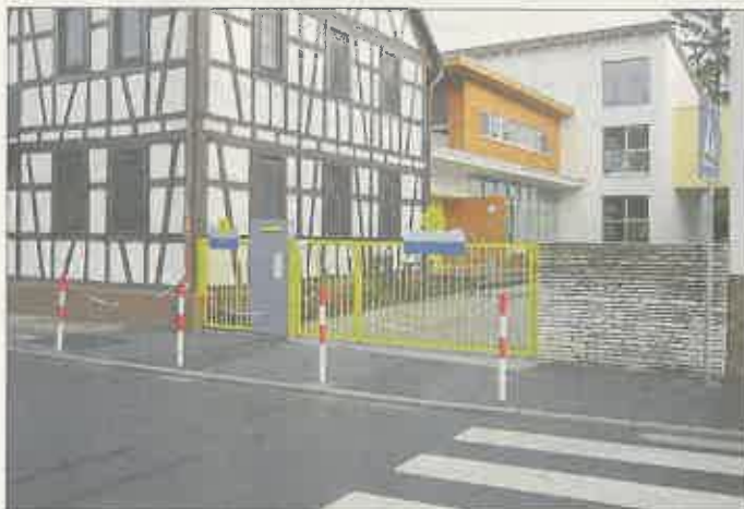
Gefährlich: Das Eingangstor der Kita Sonnenschein in Erfelden liegt direkt an der Hauptdurchgangsstraße
