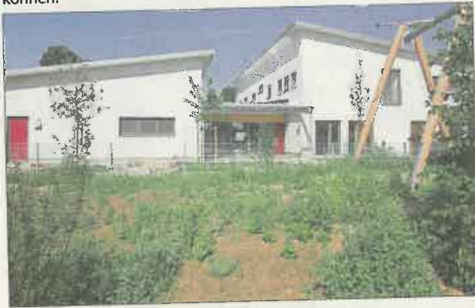
Zwischen der Straße (Philippsanlage) und dem Eingang zur „Kita am Park“ liegen ein Fußweg und ein Grünstreifen
