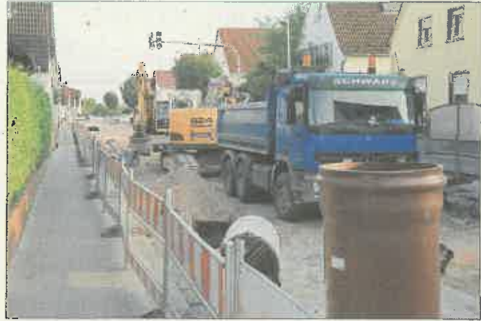
Großbaustelle Erfelder Straße
