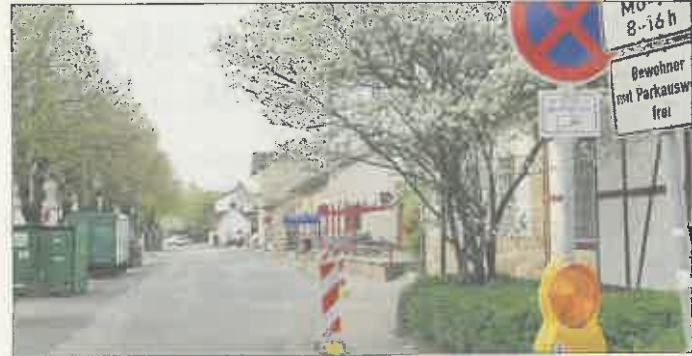
Die Bushaltestelle am Bahnhof Goddelau wird barrierefrei ausgebaut
