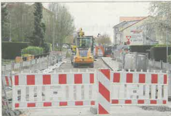
Straßensanierung in der Freiherr-vom-Stein-Straße
