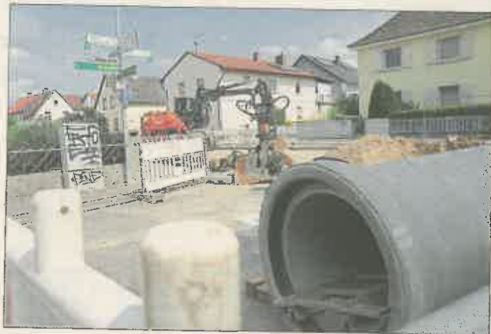
Kanalbaustelle in Goddellau (Foto: haza-foto.com)
