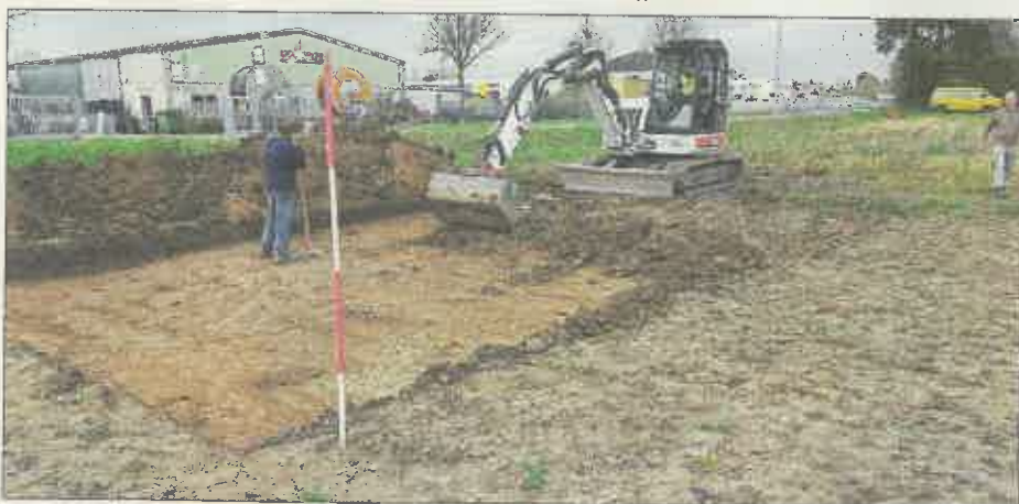
Erste Erdbewegungen am Baugelände für den Neubau des Feuerwehrgerätehauses in Crumstadt.
