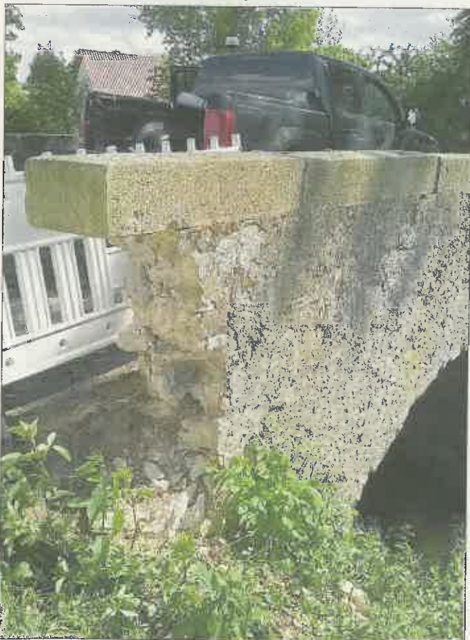
Die Brücke wurde durch den Bauhof abgesichert
