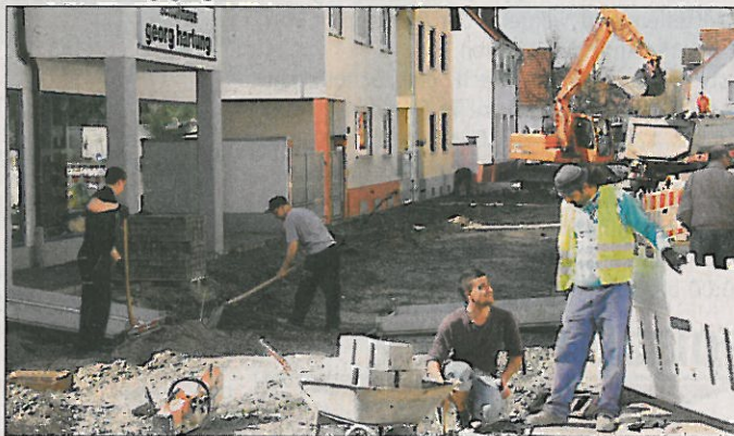
Mit den wärmeren Temperaturen kommt die Baustelle an der Bahnhofstraße wieder auf Touren
