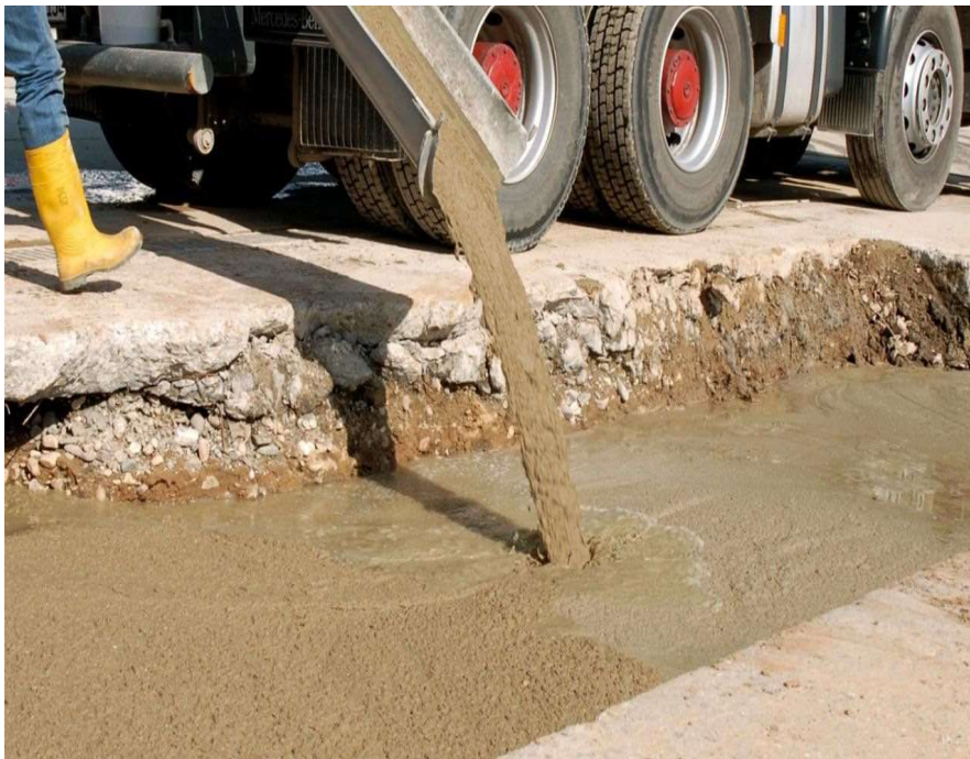
Darstellung der Flüssigbodenherstellung; hier RSS Flüssigboden®
