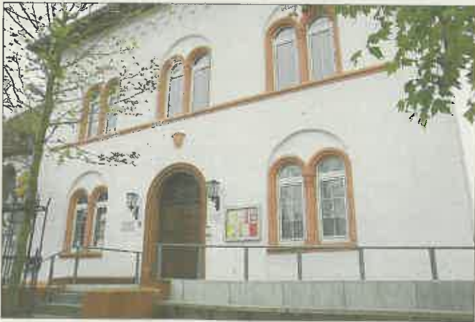
Das denkmalgeschützte ehemalige Rathaus im Stadtteil Crumstadt.
