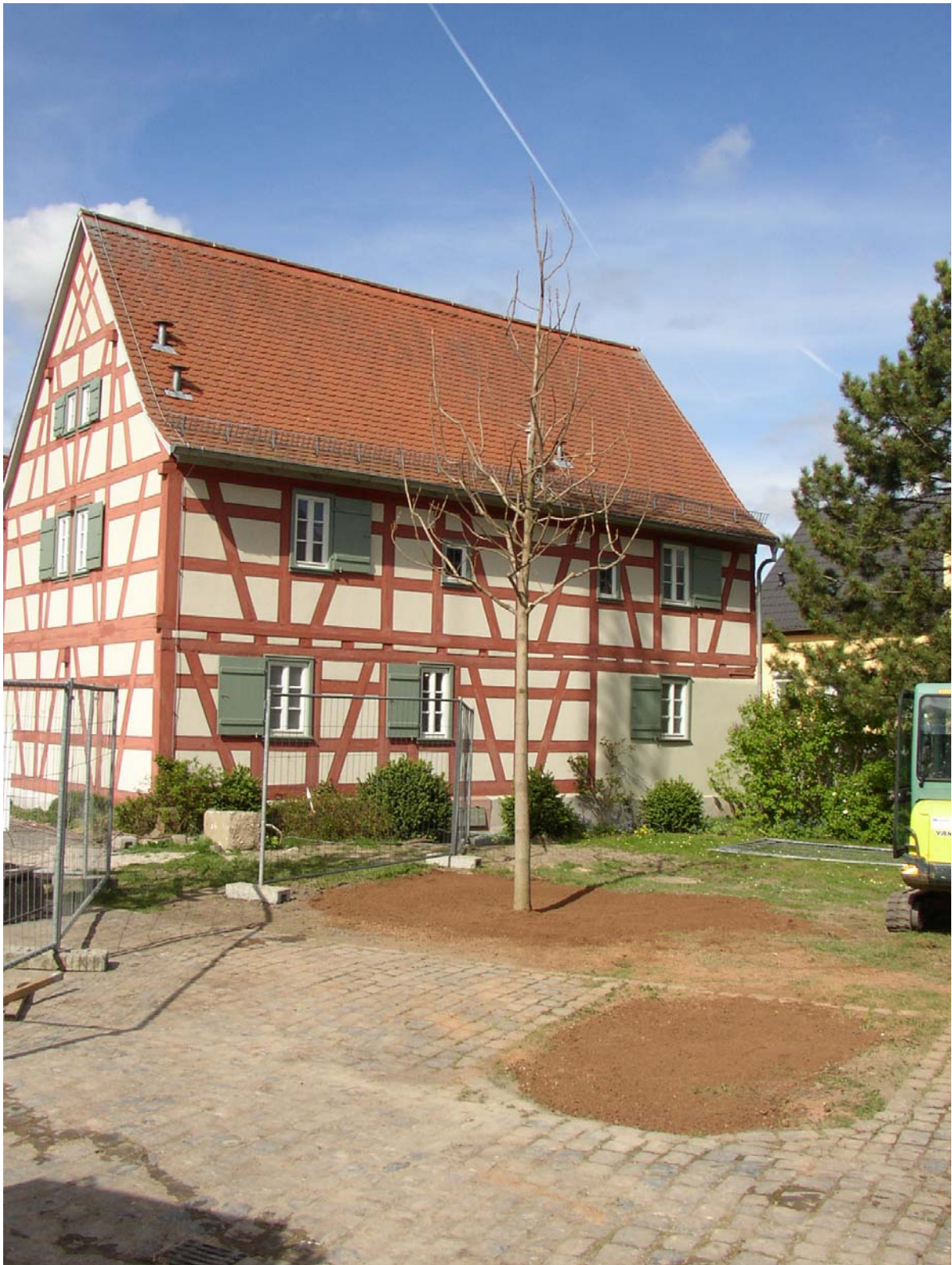
Fertig gepflanzter Baum mit Unterflurverankerung. Gepflanzt in Darmstädter Baums substrat.
