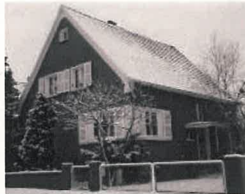
Zustand vor der Sanierung
