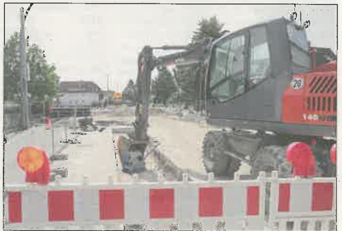
Kanalbaustelle in Goddelau (Foto: haza-foto.com)
