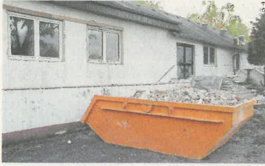
Baustopp am „Dreimaster“ in Erfelden (Foto: Stadt Riedstadt)
