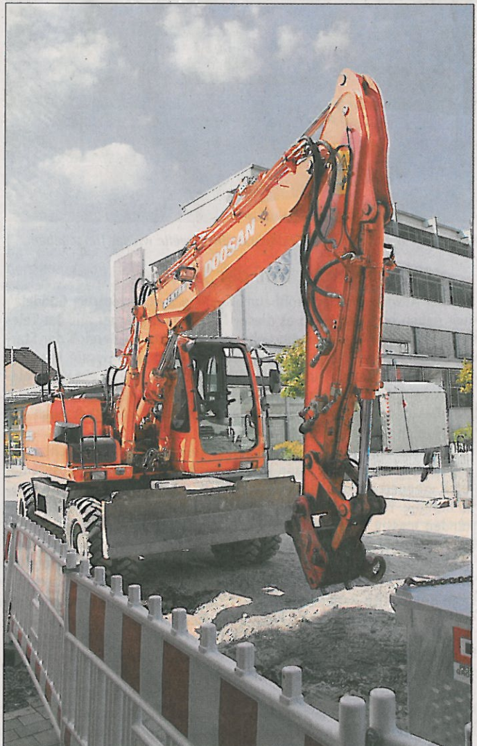
Die Großbaustelle geht entlang der Bahnhofstraße weiter
